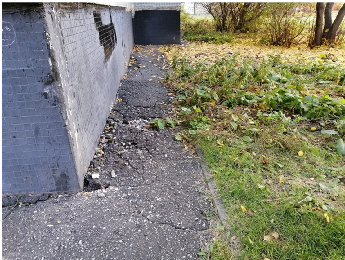
Рис.№3. Состояние отмонок.
